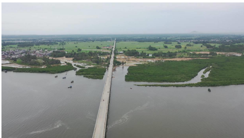
拟建新州特大桥北端接岸处红树林分布现状（2023.06）
