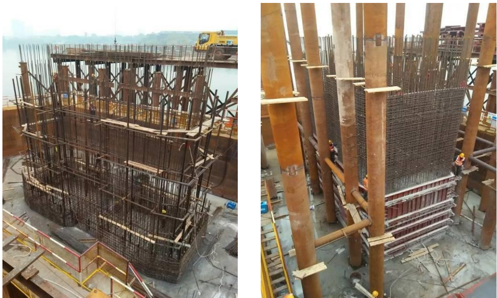
图 2.10-8 模板吊装和钢筋吊装示意图
