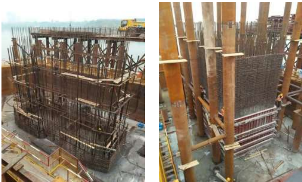
图 2.10-8 模板吊装和钢筋吊装示意图
