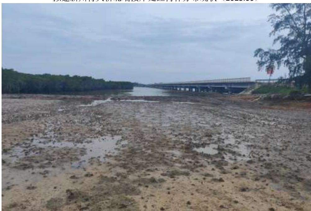
拟建新州特大桥北端接岸处（春马大桥东侧）红树林已移植区域现状（2023.06）
